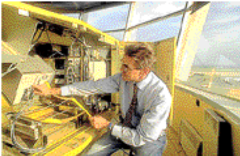
Vue intérieure de la tour de l'aéroport de Paris-Orly. Maintenance réalisée par l'arrière d'un pupitre.
