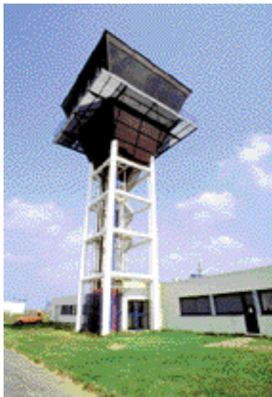
Tour de contrôle de l'aéroport de Rouen. Fût métallique.
