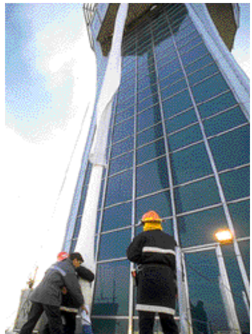
Manche textile d'évacuation incendie de la tour de contrôle de Paris-Orly.
