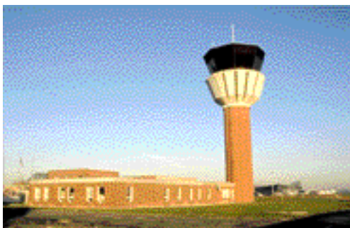
Bloc technique et tour de contrôle de l'aéroport de Lille-Lesquin.
