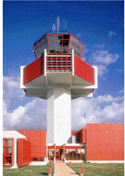
Tour de contrôle de l'aéroport de Tahiti-Faa'a. Fût non habitable.
