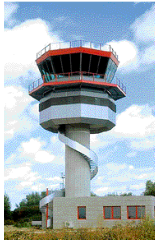
Tour de contrôle de Melun-Villaroche.
